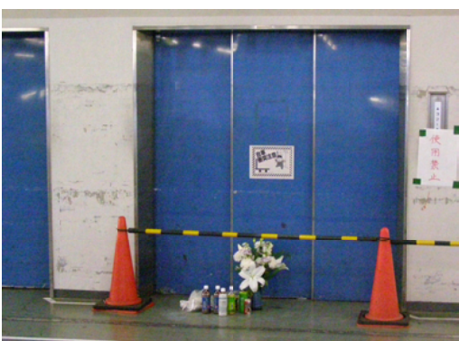
事故にあったエレベーター。隣と同型エレベーターは今もなお使用されている。
