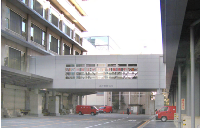
渡り廊下。左が事故が発生した本館(旧・南部小包局)右が新館。本館側が50cm高くなっている。
