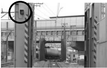
2台の洗浄機。写真には写っていないがこの手前に入替信号機があり、さらにその手前に踏切がある。左上の円内がランプ。奥が事故の起きたポイント
